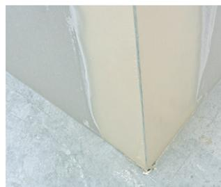
6. Terminar con una tercera capa cuando la anterior está seca dejando un acabado liso. Reparación de esquina: Se debe reemplazar solo la sección dañada, siguiendo los pasos antes mencionados.
