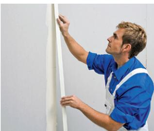
3. Plisar la Cinta con Fleje Metálico en su centro de tal manera que los flejes metálicos queden adentro y deben tener contacto con la masilla.
