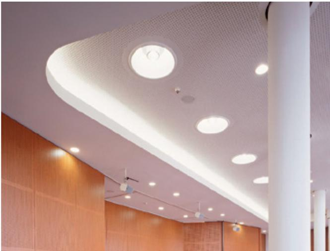
Knauf Multiform es una línea de piezas de yeso-cartón prefabricadas especialmente para el diseño creativo de espacios interiores. Mediante de fresado V, corte, plegado y pegado se consigue distintas formas geométricas.
